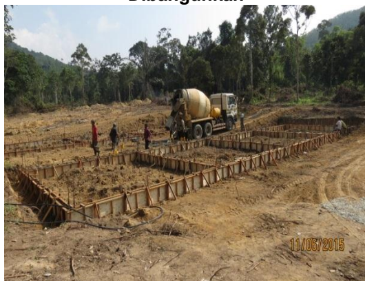
Gambar 3.1 Tanah Wakaf Khas Madrasah Sedang Dibangunkan
