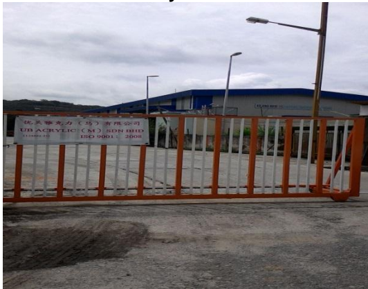
Gambar 1.4 Kilang Pembuatan Bahan Acrylic Yang Belum Mendapat Kelulusan Pelan Mekanikal Dan Elektrikal Daripada Jabatan Bomba Dan Penyelamat
