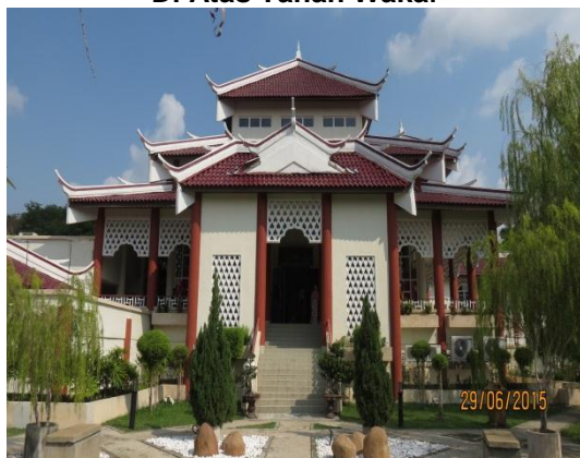
Gambar 3.7 Pembangunan Kompleks Al-Sa'adah Bukan Di Atas Tanah Wakaf
