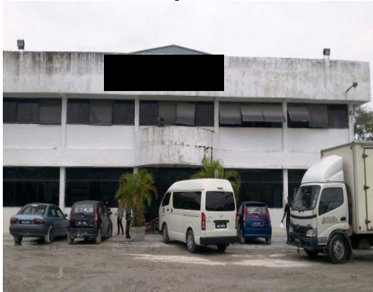
Gambar 1.1 Kilang Pembuatan Bahan Konkrit Beroperasi Dengan Lesen Sementara Kerana Tiada Sijil Perakuan Kelayakan Menduduki
